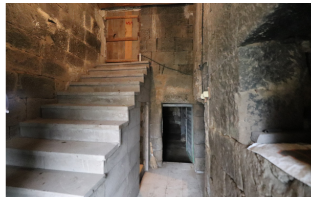
Fig. 2 - The taşlık and modern staircase
